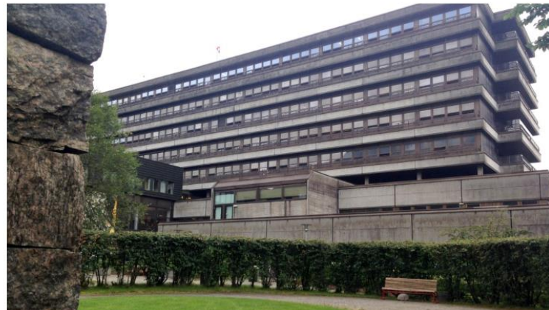
TRENG OPPRUSTING: Førde sentralsjukehus på Vie i Førde er frå 1979, og treng sårt ein opprusting FOTO: RUNE FOSSUM / NRK
